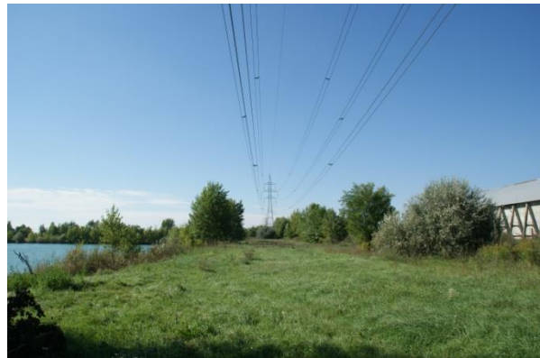
A tó északnyugati oldalán futó 220 kV-os elektromos vezeték
